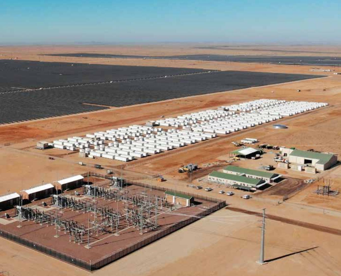
Figur 1. Det batteristøttede solkraftverket Kenhardt i Sør-Afrika som eies og driftes av det norske selskapet Scatec var verdens største prosjekt av sitt slag da det ble satt i drift. Kraftverket er utviklet for å være basekraft og leverer 150 MW effekt 16,5 timer om dagen hver eneste dag.
